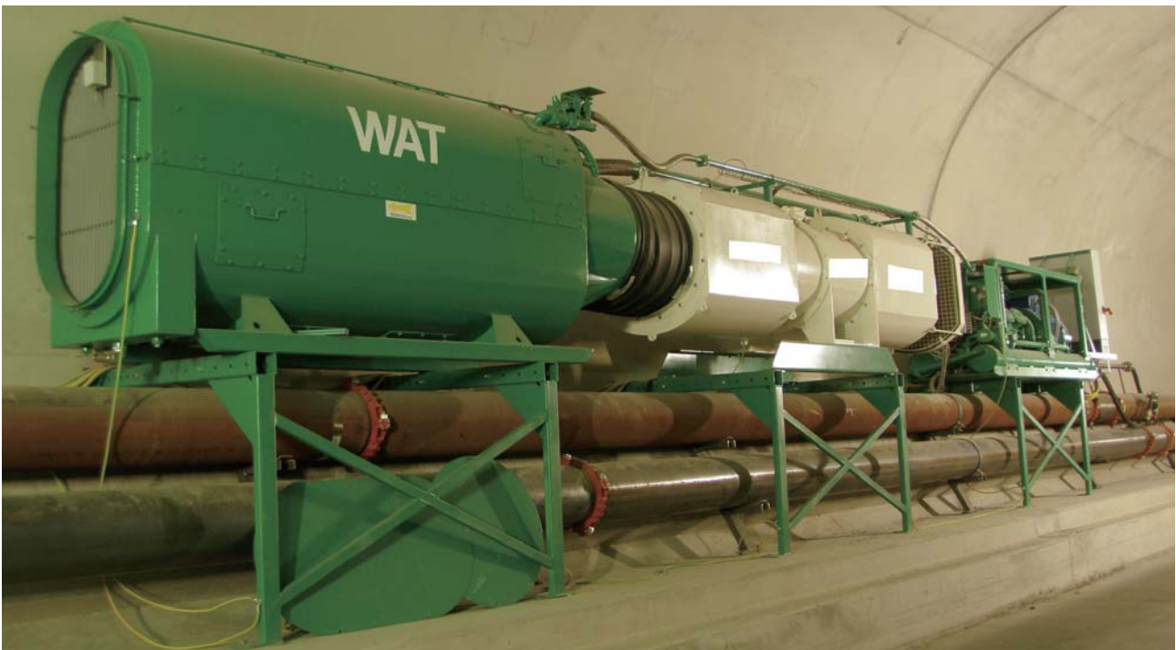
设备调试现场
